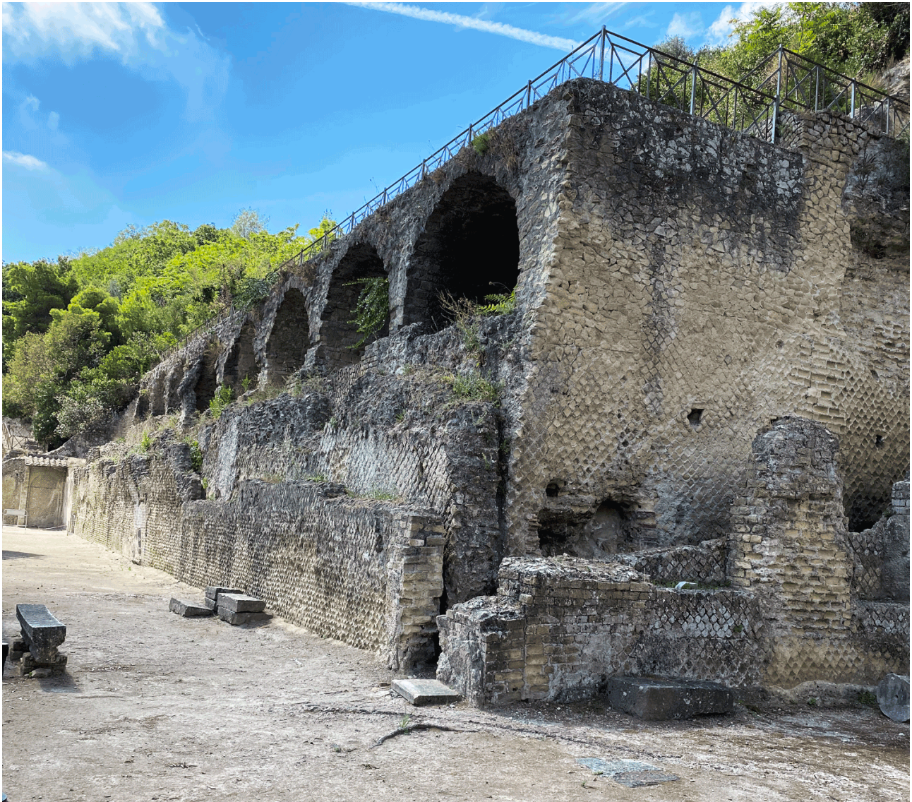
La cisterna vista dal criptoportico col particolare delle mura
