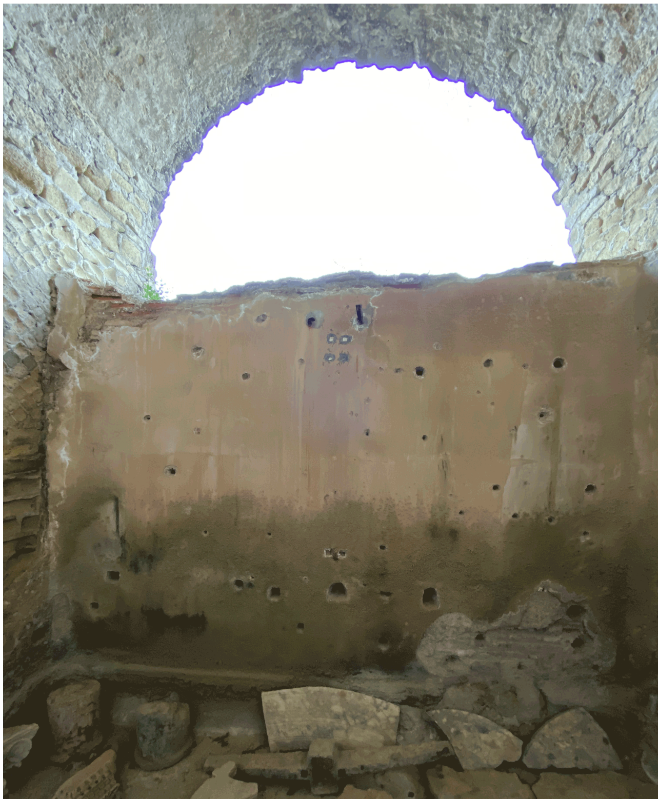
La parete destra della stanza n. 6 - Come si vede la metà della parte bassa è ricoperta dalle concrezioni calcaree.
