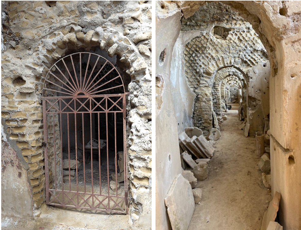
L'ingresso e l'interno della cisterna
